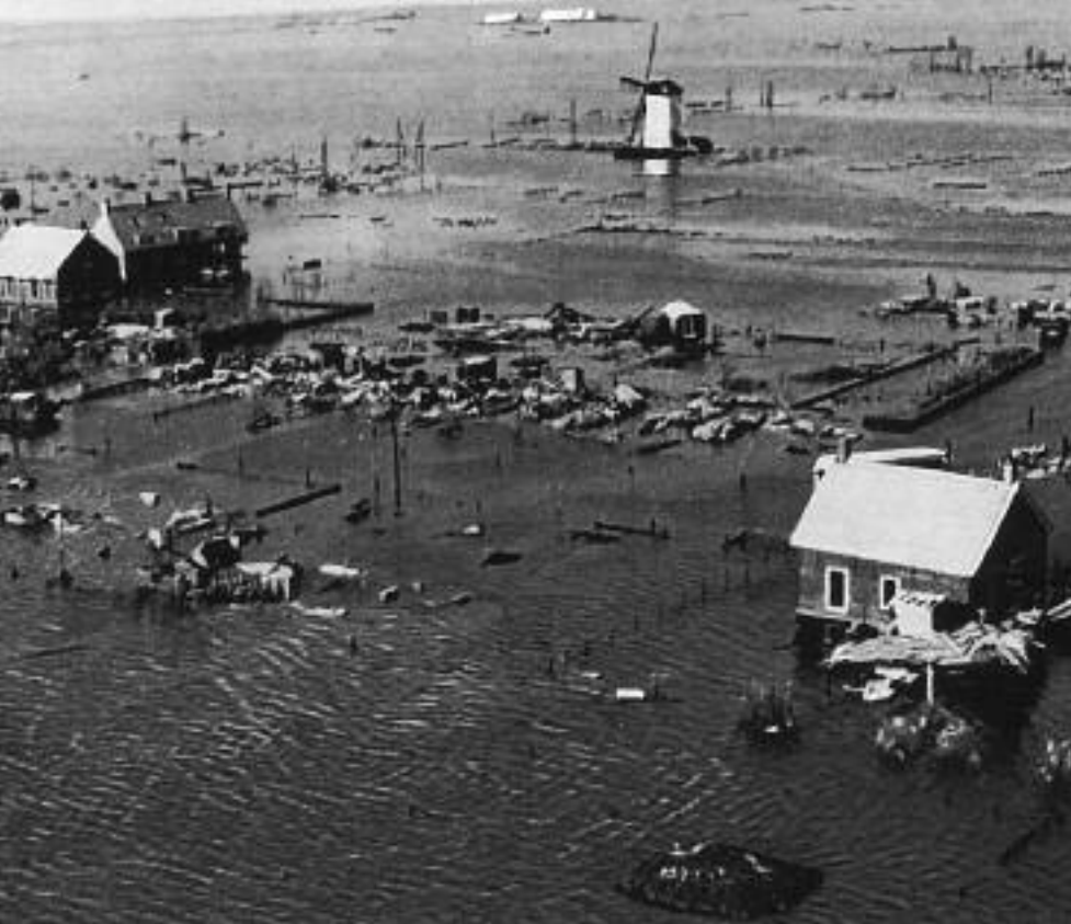
Zerstört: Hier standen geschlossene Häuserzeilen.
